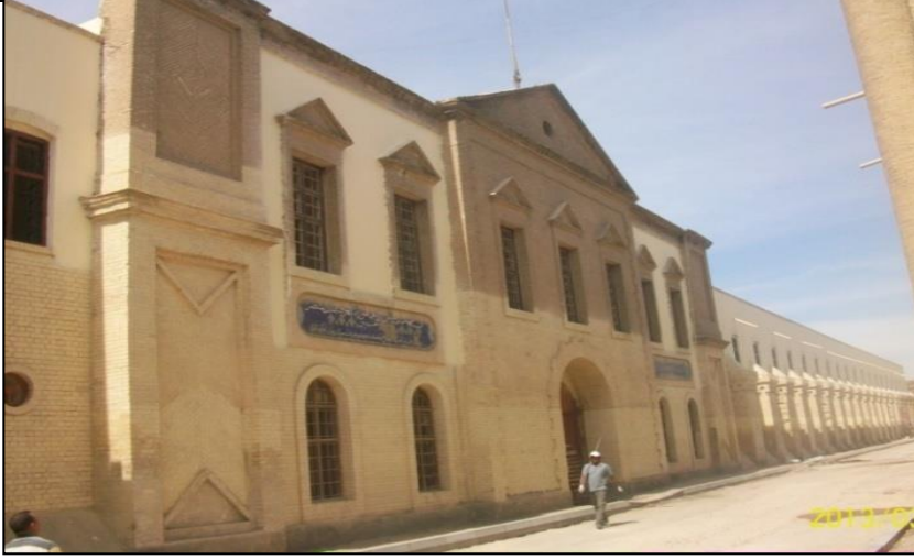
(الصورة - ٢) الواجهة الخارجية المطلة على شارع جديد حسن
